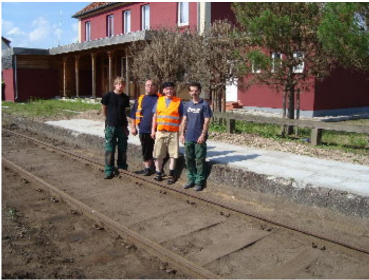
Neuer Bahnsteig in Bleckede: AVL-Mitglieder im Einsatz
